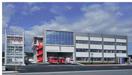
四日市市中消防署中央分署
